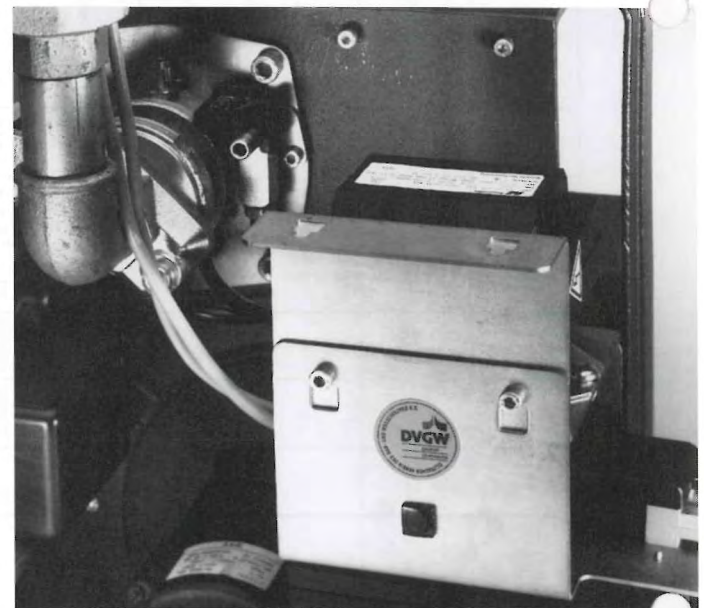
Abb. 35 Steuereinheit abgenommen Fig. 35 Control unit removed Fig. 35 Orange de commande retiré
