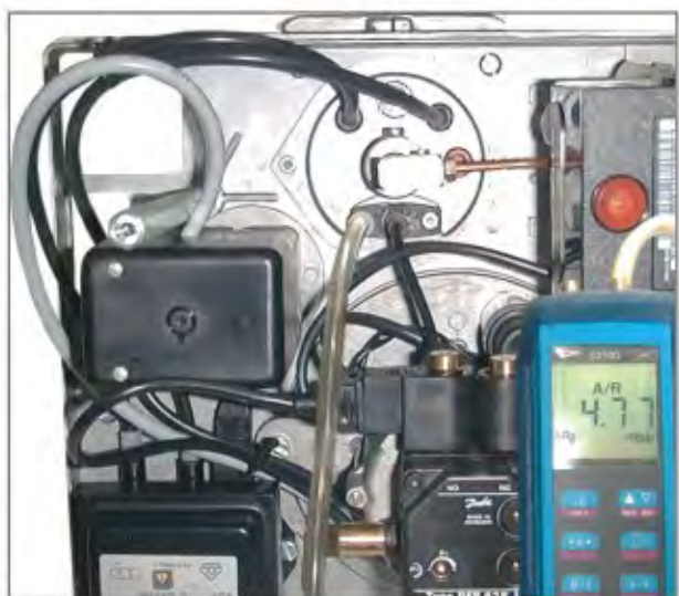
Рис. 42 Замер давления перед стабилизатором
