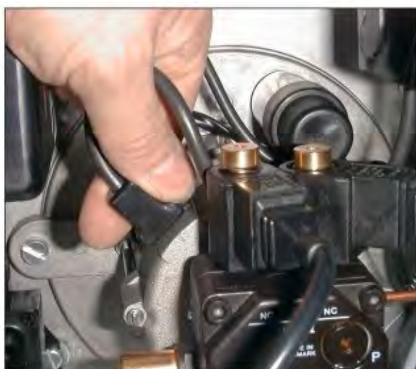
Рис. 47 Разъединение разъёма питания электродвигателя
