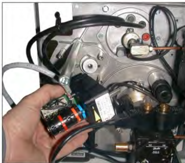
Рис. 41 Регулировка воздушной заслонки
