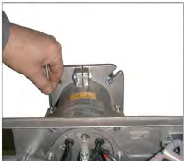
Рис. 36 Ослабление болта с целью демонтажа горелки
